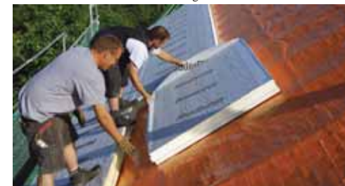
Dachdämmungen sind etwa im Rahmen einer neuen Dacheindeckung mit überschaubarem Aufwand realisierbar. Foto: djd/Paul Bauder
