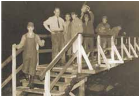
Lang ist es her: Brückenbau auf dem Gelände des Freibades Eslohe
