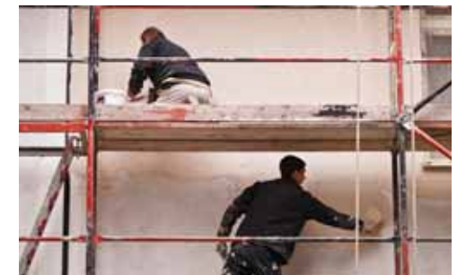
Effiziente Dämmung und Fassadenanstrich gehören zur Altbauanierung. Foto: Bauherrenschutzbund (BSB)
