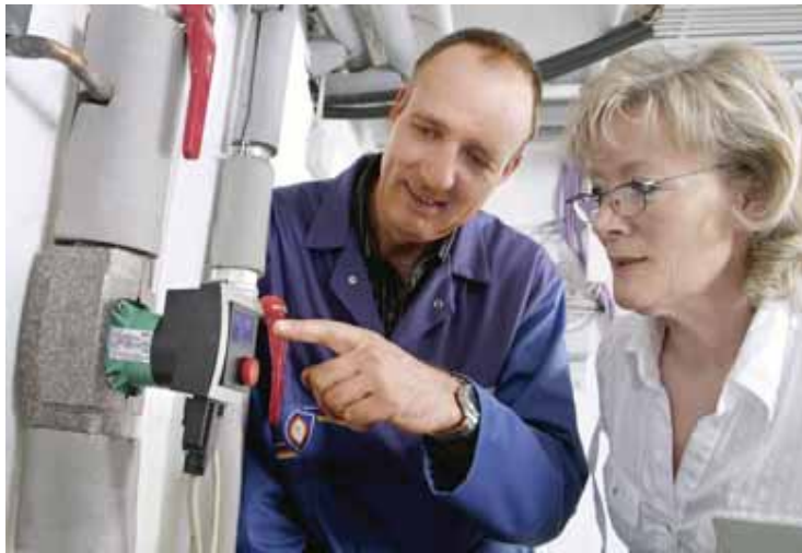
Wer eine veraltete Pumpe gegen eine moderne Hocheffizienzpumpe auswechselt, spart beim Stromverbrauch bis zu 90 Prozent Energie ein. Damit verringern sich die laufenden Kosten erheblich, auch Energieressourcen und die Umwelt werden geschont. Foto: djd/Wilo
