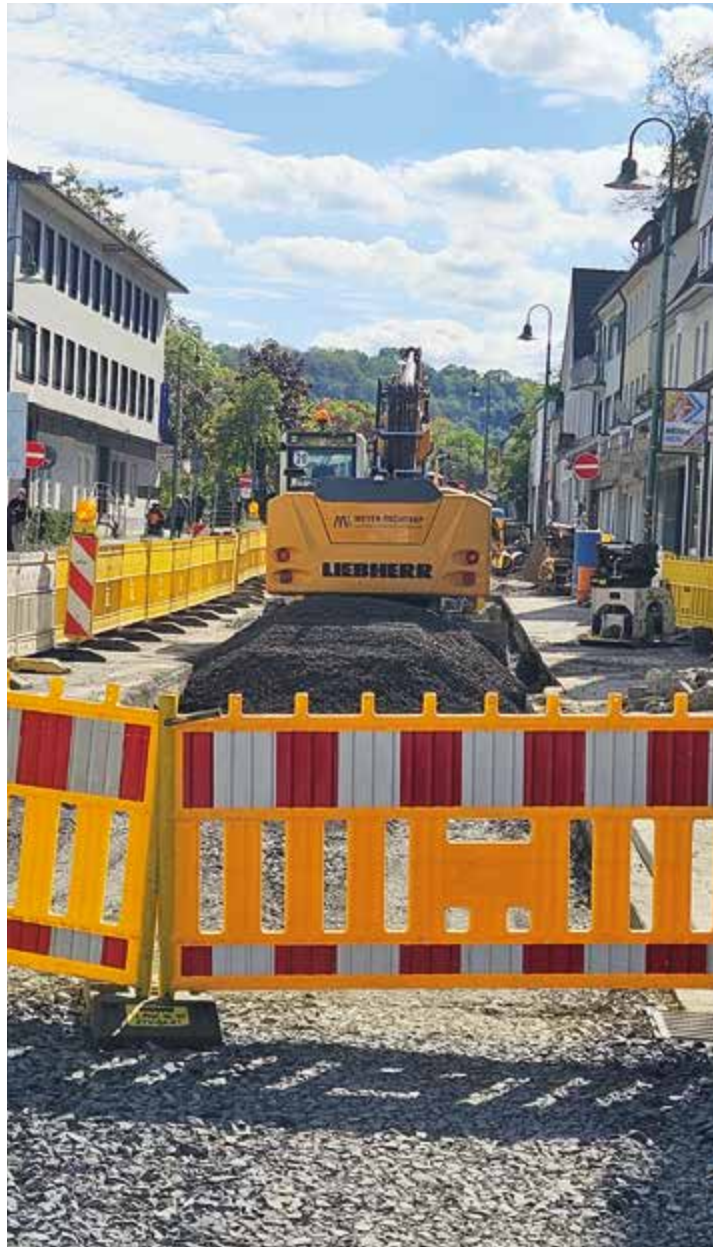
Baustellen, Bagger und Absperrungen bestimmen derzeit das Warsteiner Stadtleben. Fotos: MS/F.K.W. Verlag
